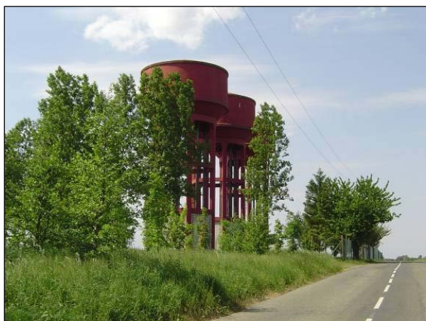
Réservoirs de Guillaucourt
