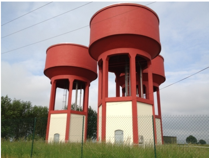
Réservoirs de Licourt
