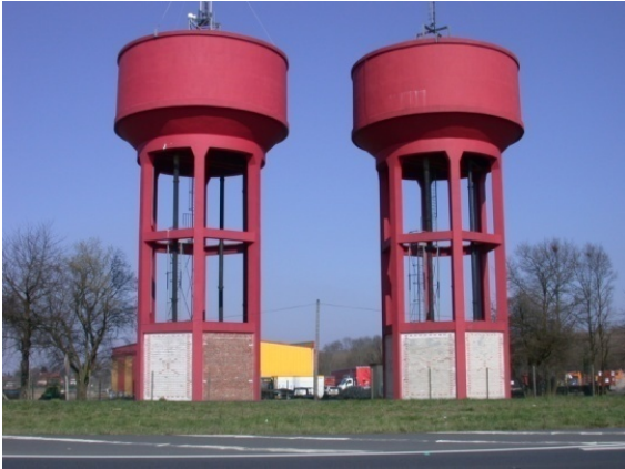
Réservoirs de Le Quesnel
