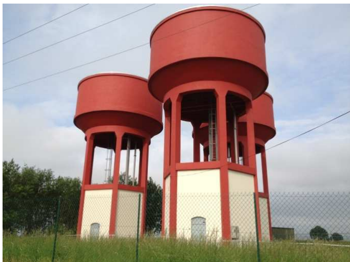
Réservoirs de Licourt
