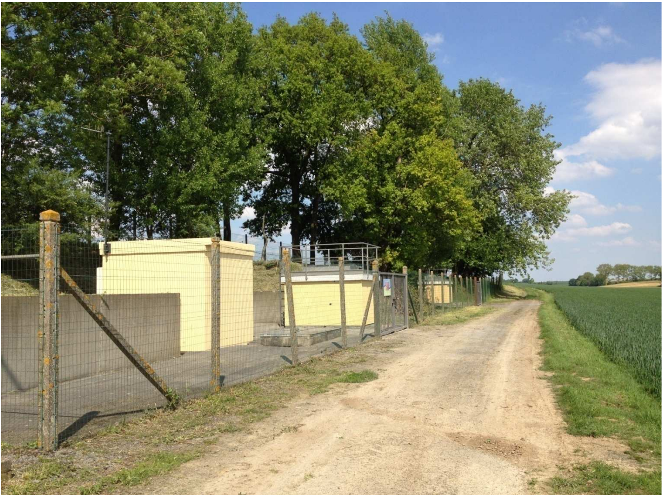
Station de Pompage de Potte
