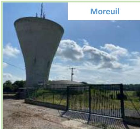
**Volume total** : 2300 m<sup>3</sup> : 2x900 m<sup>3</sup> sur tour et 500 m<sup>3</sup> semi enterré. Le semi enterré de 200 m<sup>3</sup> a été déconstruit en 2020.
