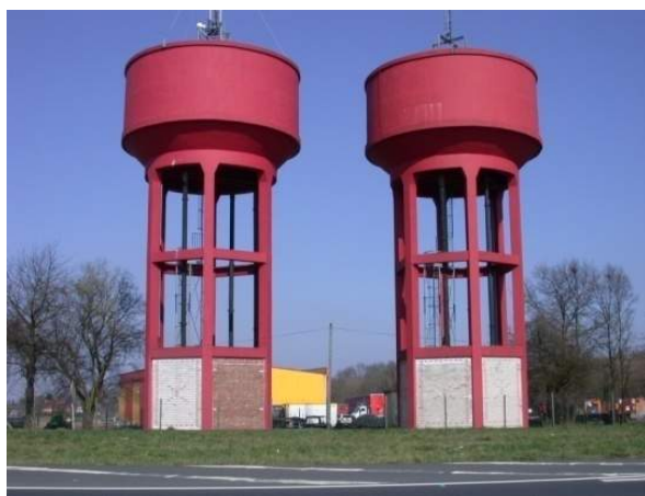
Réservoirs de Le Quesnel
